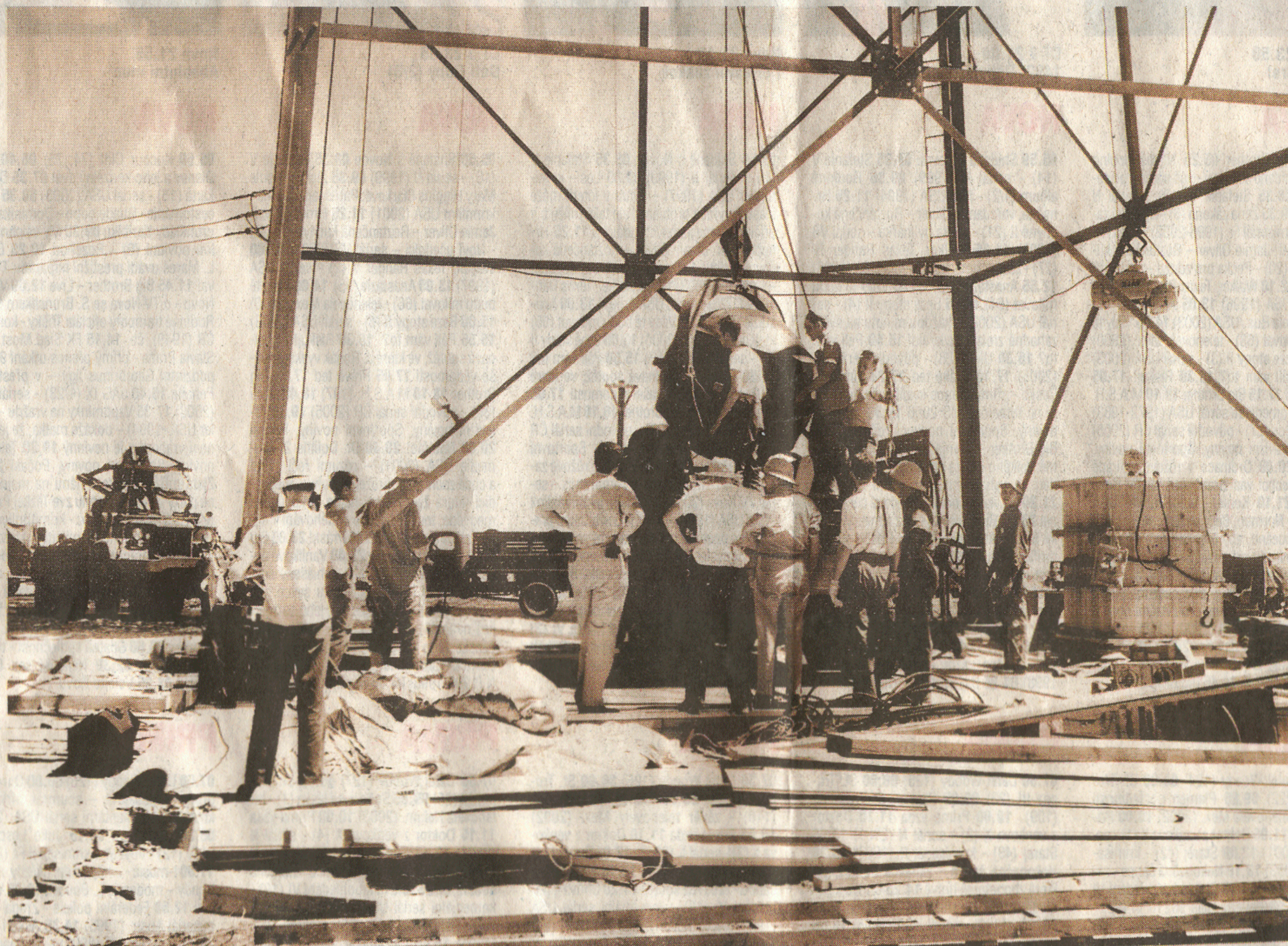
PŘÍPRAVA BOMBY. Na dobovém snímku vědci a technici připravují stavbu stometrové věže a instalují první atomovou bombu světa. Zkušební výbuch bomby Trinity o síle asi 20 kiloton TNT, první výstup projektu Manhattan, se odehrál 16. července 1945. FOTO: AP
